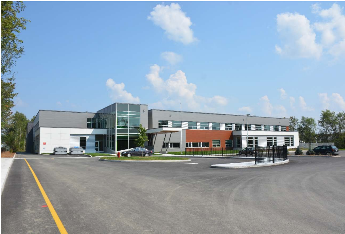
L'école des Aventuriers, août 2015. (Photo du Service des communications, CSRS)
