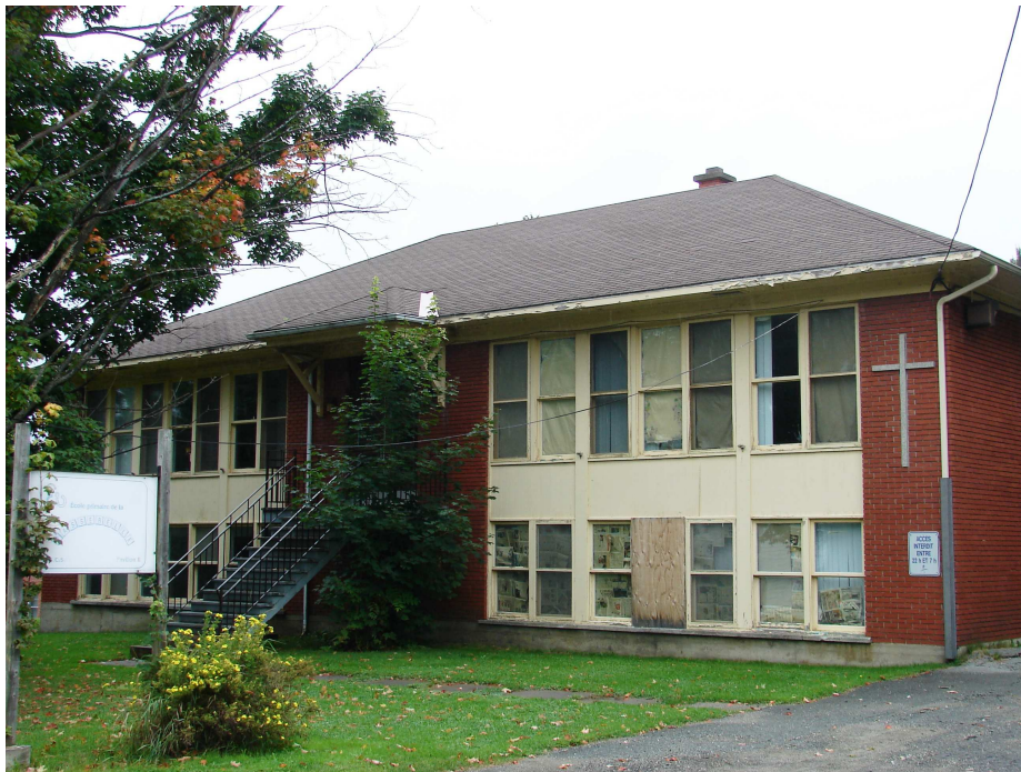
L'ancien pavillon no 2 de l'école de la Passerelle, août 2010. (Photo par Alexis Dubois-Campagna, CSRS)
