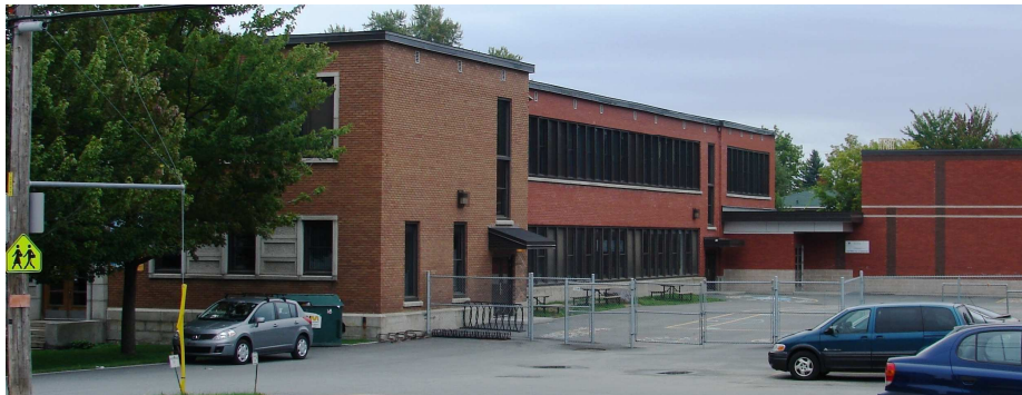
Pavillon de la rue Belvédère (anciennement Bussière), août 2010. (Photo par Alexis Dubois-Campagna, CSRS)
